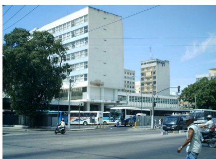
VISTA DA RODOVIÁRIA DE NITERÓI
